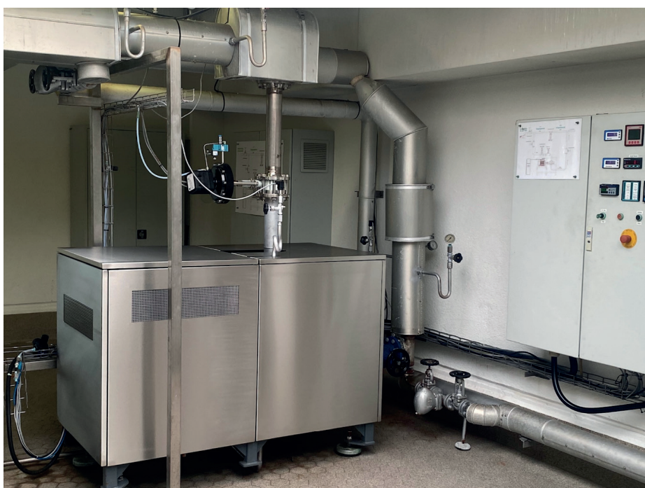
Aufstellung des Energiemoduls
